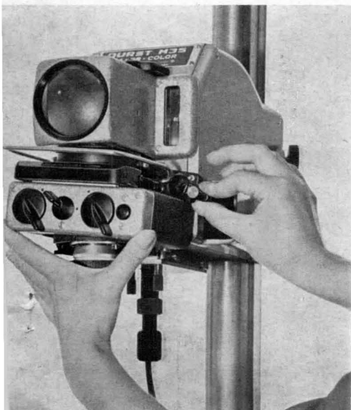
Fig. 1 a et 1 b. Dispositif d'inclinaison du porte-négatif du Durst M 35 :
